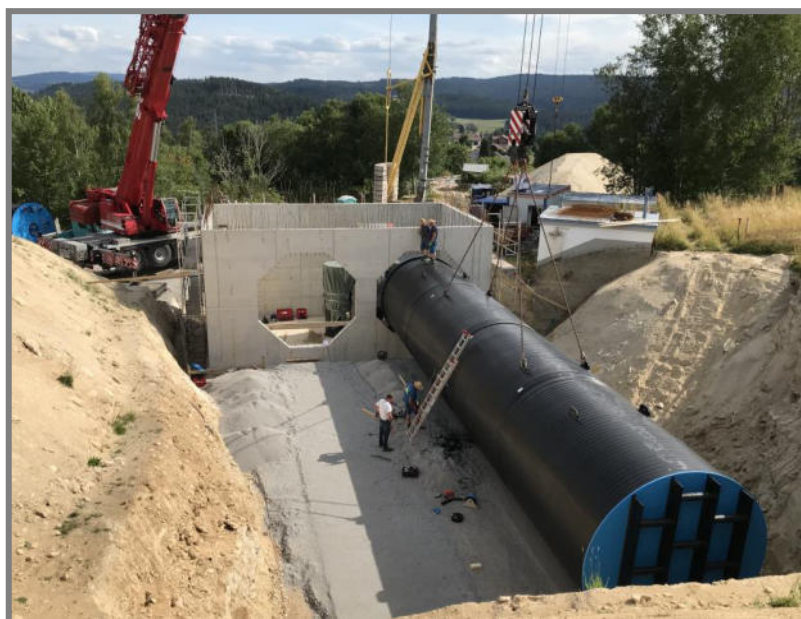
Baumaßnahme Hochbehälter Schweinhütt
